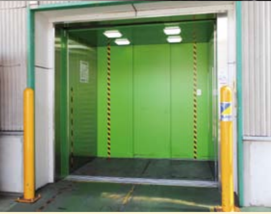
防府港マツダ車ストックヤード
