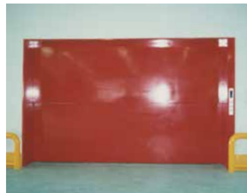
ロープ式大型エレベーター第1号
