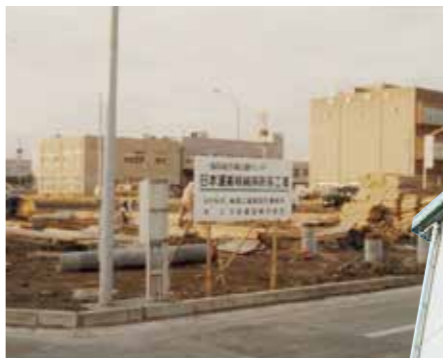
昭和55年 本社新築の為の土地を購入
