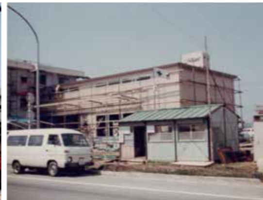
昭和56年 工場建設
