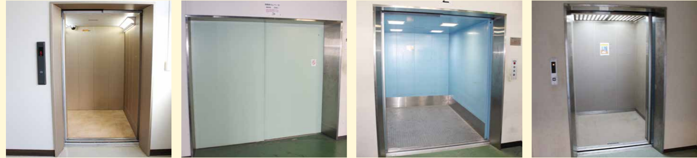
[本社] 納 入/1984年11月 型 式/ロープ式 積 載/人荷共用 1,000kg 15名 ケーヅ寸法(mm)/1500W×1600L×2100H [第一流通センター] 納 入/1988年6月 型 式/ロープ式 積 載/荷物用 1,500kg ケーヅ寸法(mm)/2200W×2400L×1900H [第二流通センター] 納 入/1993年2月 型 式/ロープ式 積 載/荷物用 1,250kg ケーヅ寸法(mm)/2000W×2450L×2100H [社宅] 納 入/1990年11月 型 式/ロープ式 積 載/乗用 1,000kg 15名 ケーヅ寸法(mm)/1500W×1600L×2250H
