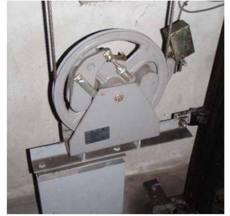
エレベーターは、日頃より皆様に安全にご使用いただけるよう、全ての搬機に安全装置が装備されており、安全に使用いただけるよう、全ての搬機に安全装置が装備されています。一口に安全装置と言っても様々ですが、今回は「調速機(ガバナ)」と呼ばれる制動装置についてご紹介いたします。「昇降機技術基準の解説」の中には以下のように規定されています。
